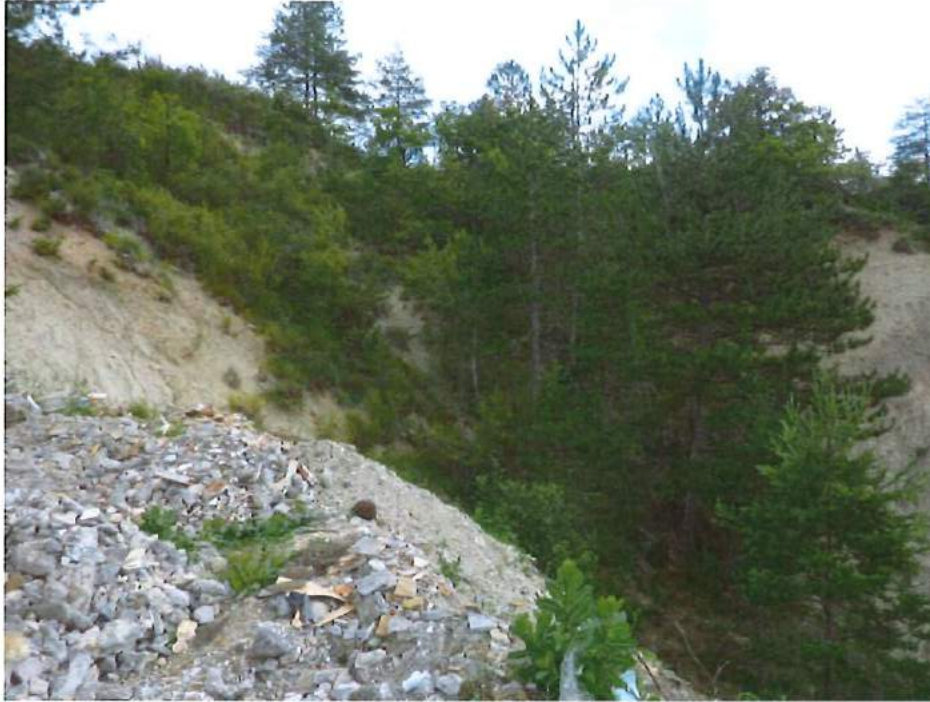
Vue du talus vers le sud du site
